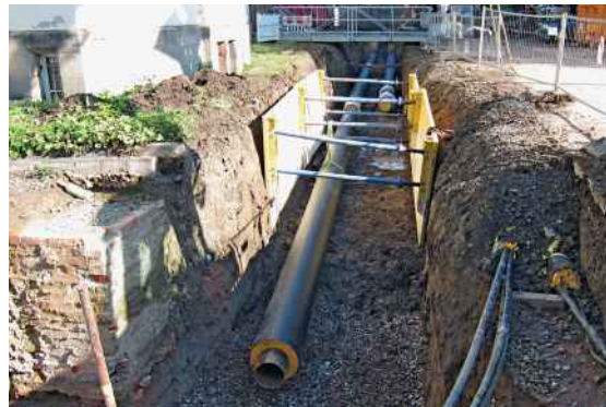
Ausbau der Fernwärme in der Göttinger Innenstadt 02
