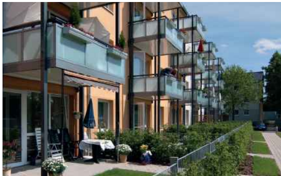
Energetische Sanierung in der Weserstraße 01
