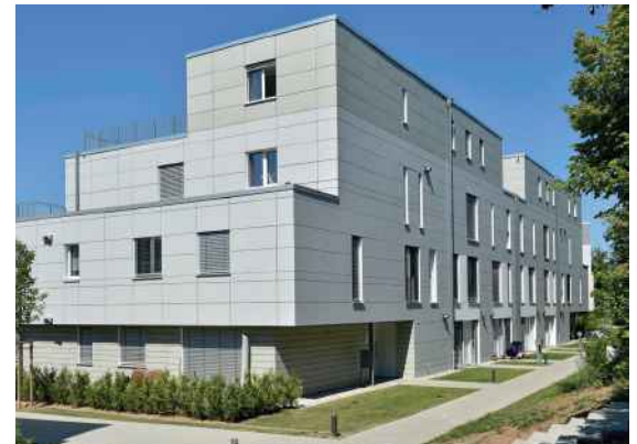
Passivhäuser auf den Zietenterrassen erfüllen hohe energetische Standards 04
