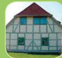
renovierte Fassade, Foto: Silke Altena
