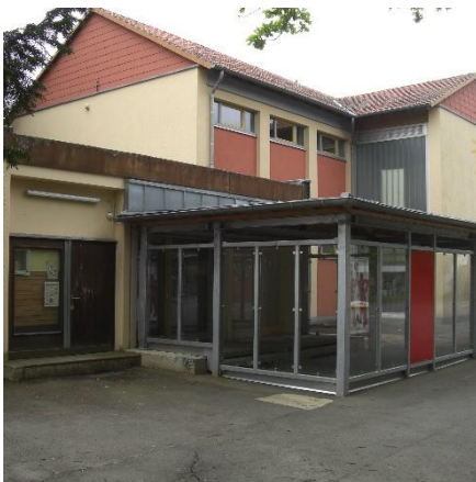
Abb. 23: Janusz-Korczak-Schule vor und nach der Sanierung
