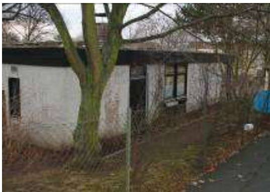
Kita Lönsweg vor und nach der Sanierung
