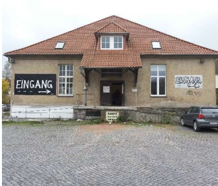
Musa e.V. vor und nach der Sanierung
