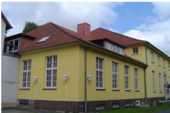
Musa e. V. vor und nach der Sanierung
