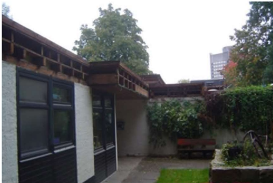
Kita Teichweg vor und nach der Sanierung
