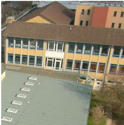
Astrid-Lindgren-Schule vor und nach der Sanierung
