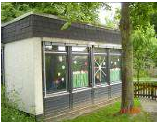
Kita Weende West vor und nach der Sanierung
