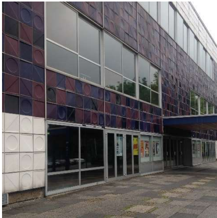
Stadthalle vor und nach der Sanierung
