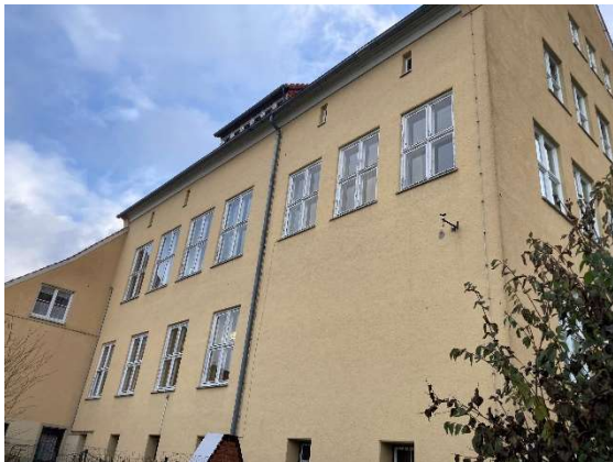
Egelsbergschule vor und nach der Sanierung
