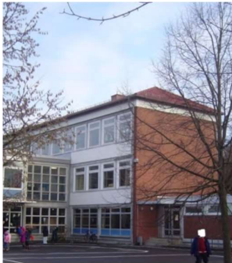
Westansicht vor und nach der Sanierung
