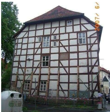
Alte Posthalterei vor und nach der Sanierung
