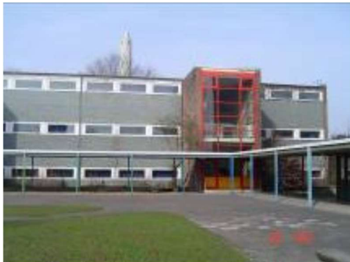
Voigt-Realschule vor und nach der Sanierung
