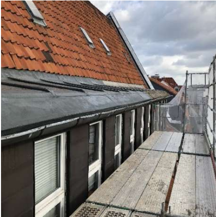
Stadtbibliothek vor und nach der Sanierung
