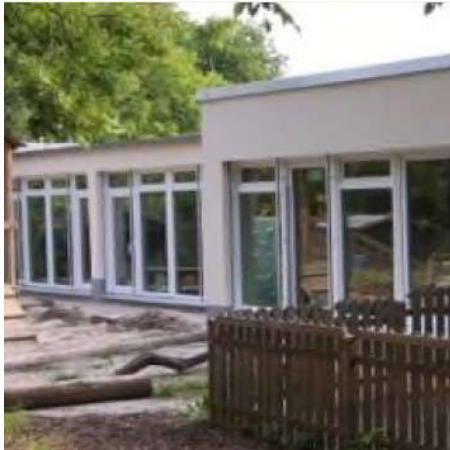
Kita Bethlehem vor und nach der Sanierung
