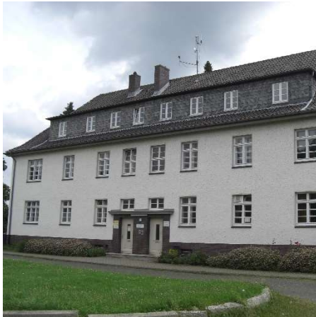
Kinderhaus Zebolon vor und nach der Sanierung
