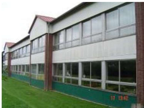
Lohbergschule vor und nach der Sanierung
