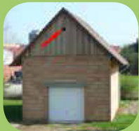
Durch das Einflugloch sollen die Fledermäuse in das Dachgeschoss des Ersatzquartieres gelan- gen, Foto: Silke Altena
